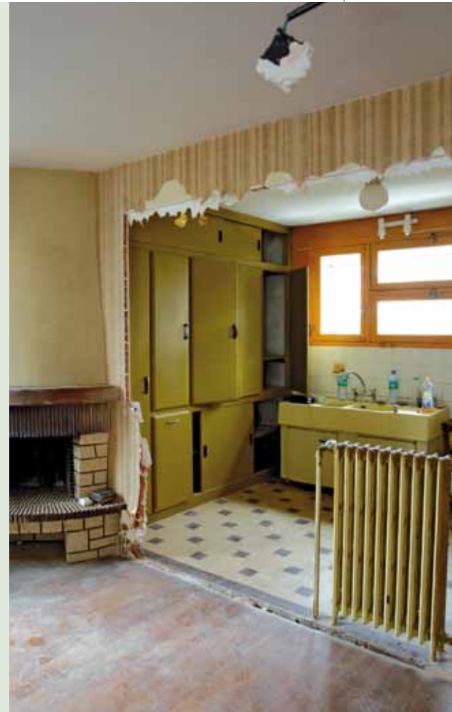
Les premières cloisons ont été cassées pour ouvrir l'espace à la lumière naturelle.
